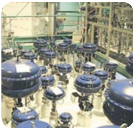
Eine Spezialanfertigung von Velan für den weltweit größten Teilchenbeschleuniger in Genf: Tieftemperaturventile für flüssiges Helium bei 1,8°C über dem absoluten Nullpunkt.
